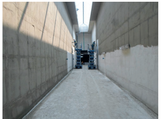
AQUAFIN®-IC 도포 후 AQUAFIN®-1K 도포 마감
