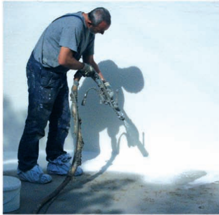
전용 스프레이를 이용한 수영장 시공
