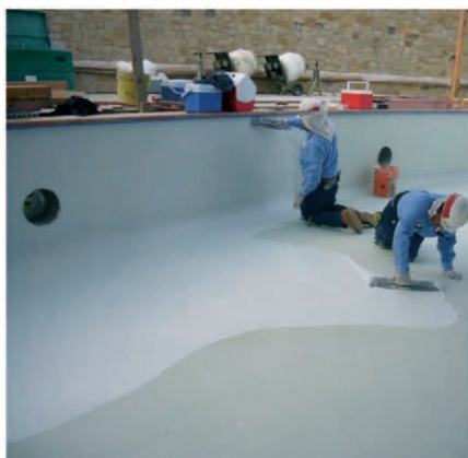
흫손을 이용한 타일 하부의 방수시공
