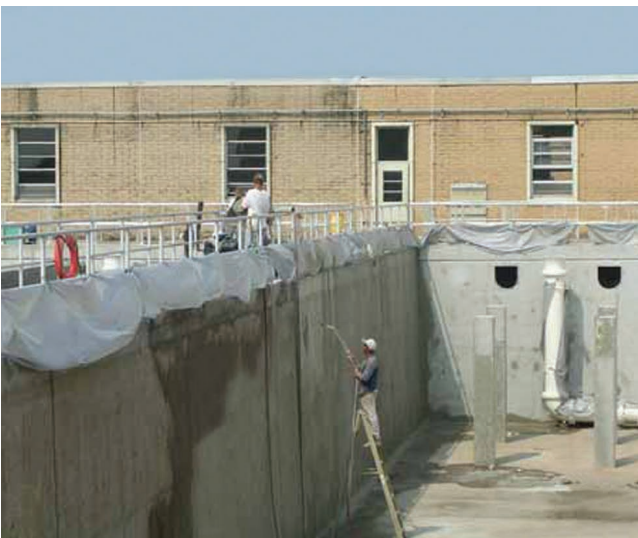
▲ 폐수처리장 시공 전경
